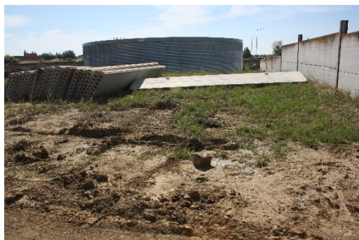
Depósito existente (e-o)
