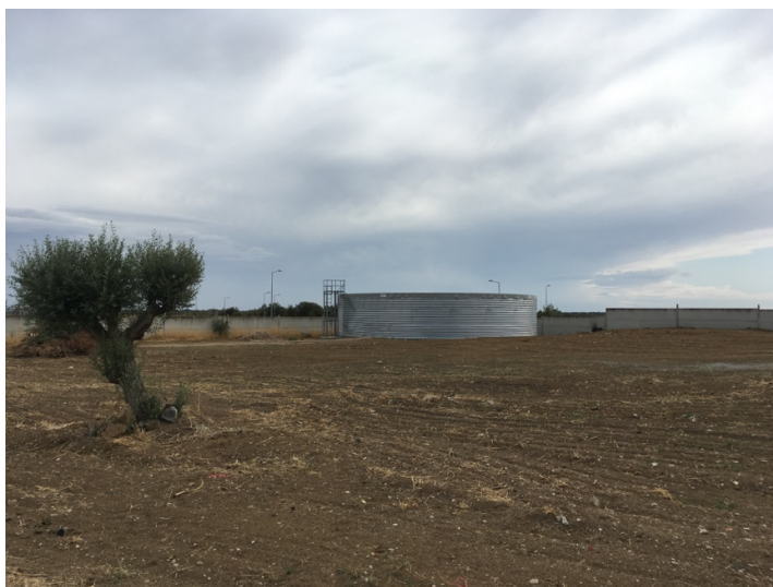
Figura 3.21 – Depósito existente a integrar na ETAR.
