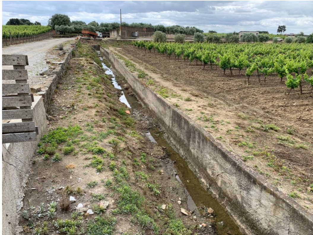
Figura 4.7.4 - Ribeiro das Fontainhas no troço onde ficará situado o ponto de descarga.
